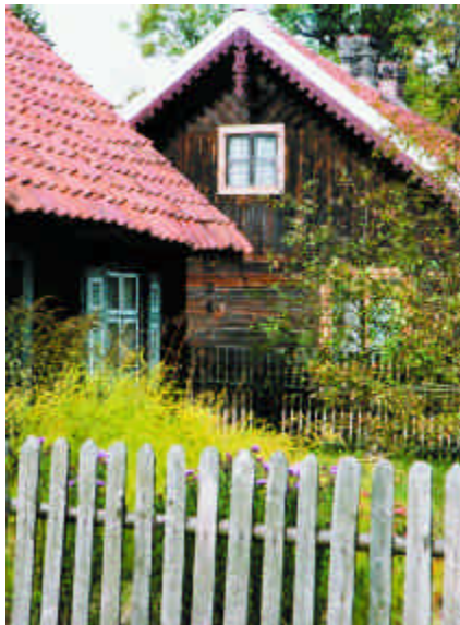
11. Faryny, ► dach dwuspadowy fot. Jacek Sztorc
