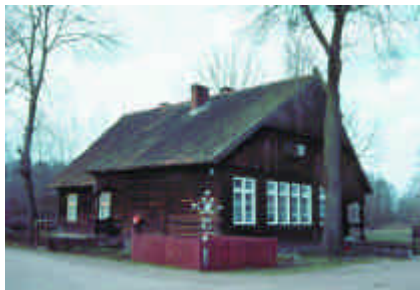
◀ 57. Typowy budynek szkolny z cegły licowej fot. Iwona Liżewska
