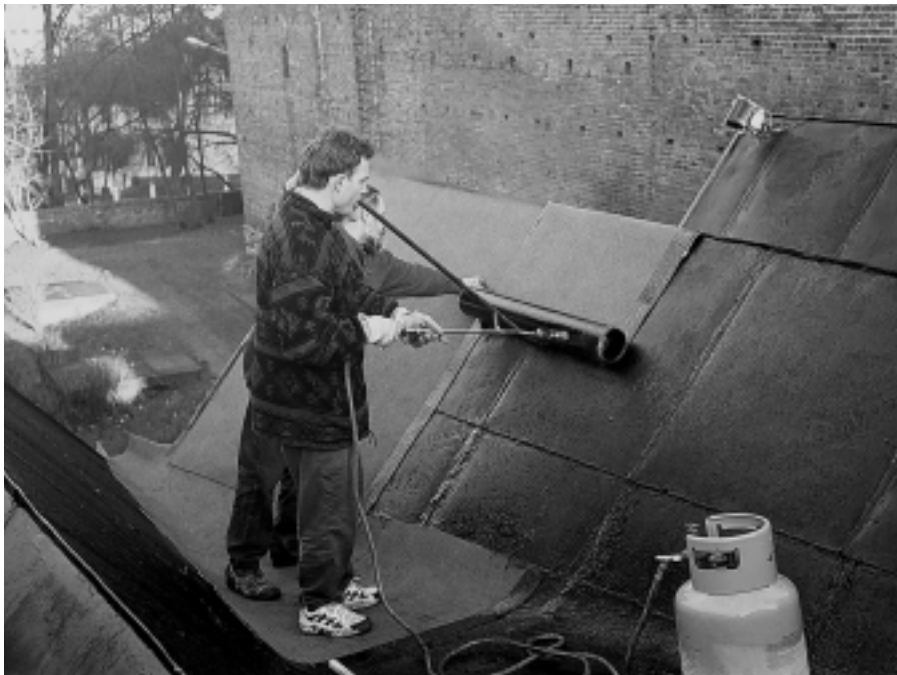
Remont dachu Galerii ZPAP, grudzień 2000
