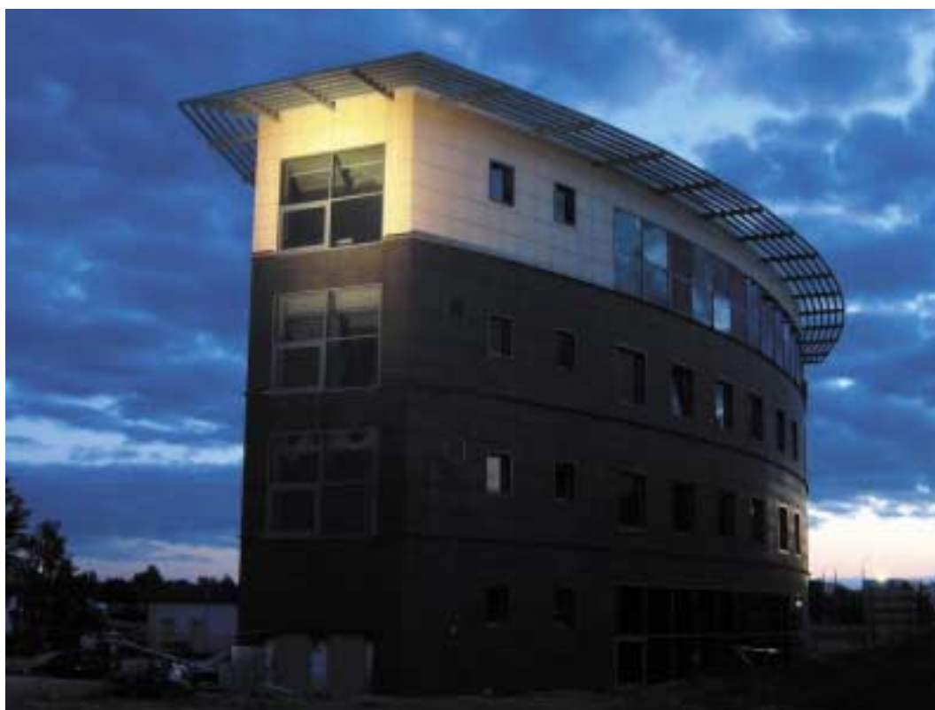
Budynek firmy „Totalpack” w Olsztynie
